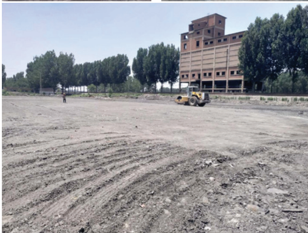
煤炭物流园二期新平整土地
