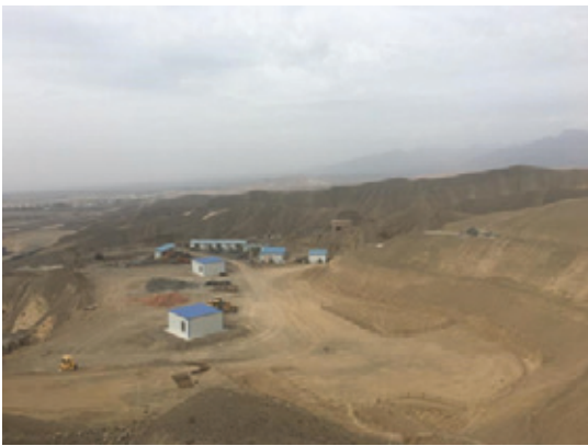
主、副井及风井工业广场
