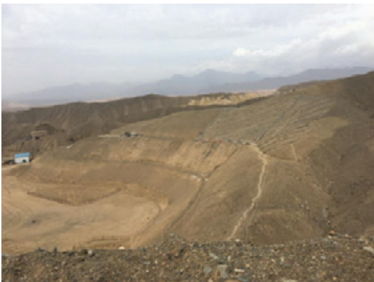
护坡改造工程
