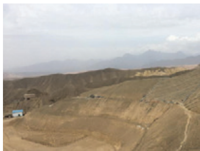
护坡改造工程
