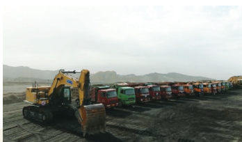
各类施工机械在矿区待机
