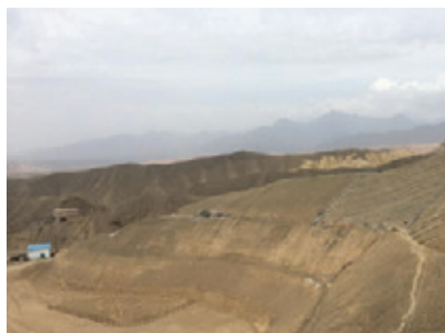
護坡改造工程
