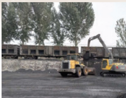
現場裝卸作業
