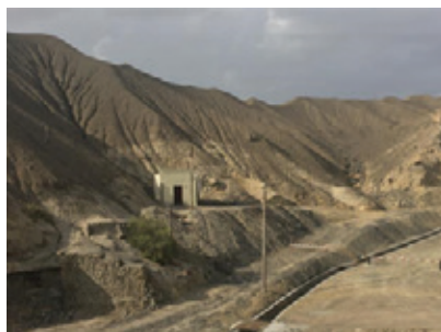
火藥庫及排水渠
